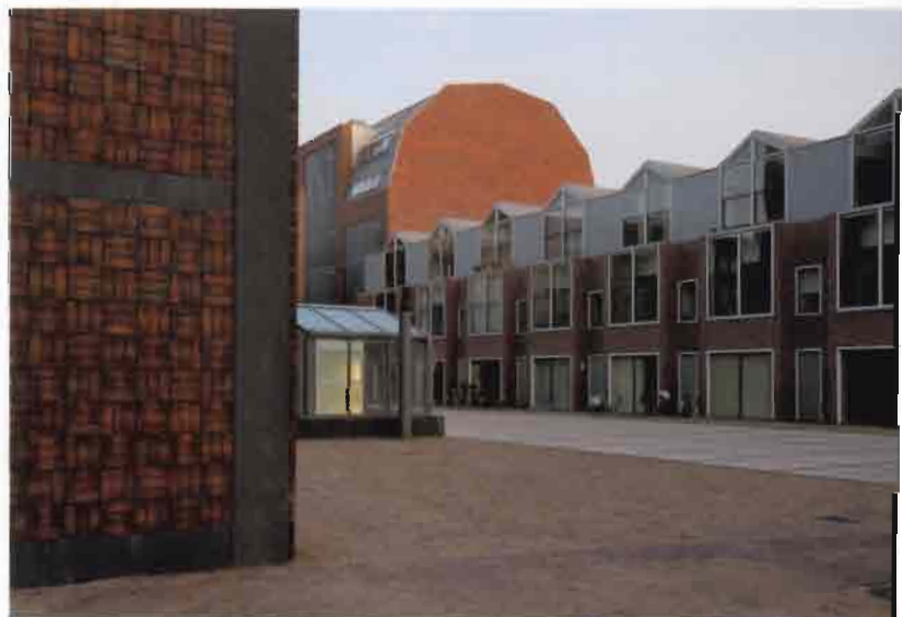
Met rode baksteengevels en fijn geprofileerde grijsmetalene beplating zijn de eengezinswoningen subtiel gedetailleerd
