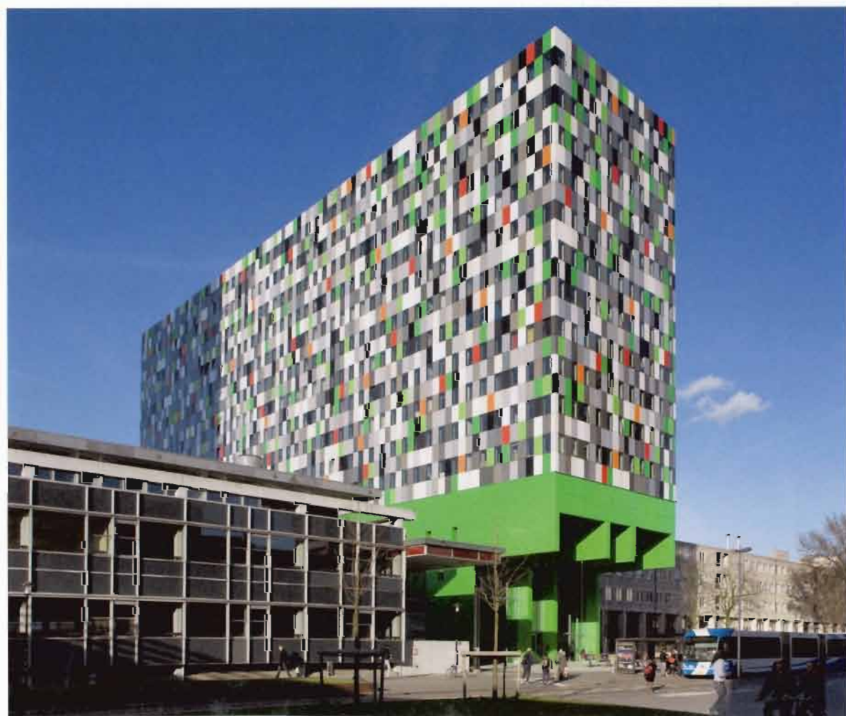
1 Boven op het dak van het gebouw bevindt zich een terras waar Architectenbureau Marlies Rohmer voor de studenten grote houten 'banken' heeft gerealiseerd. 2 De gevel, bestaande uit gekleurde aluminiumpanelen, is als een hoes om de constructie heen gevouwen. De raamopeningen vallen in het grid weg, waardoor ze bijna niet te herkennen zijn. Pas wanneer een raam wordt opgezegt, ontstaat er een geleding in de gevel, die het leven erachter verraadt.
