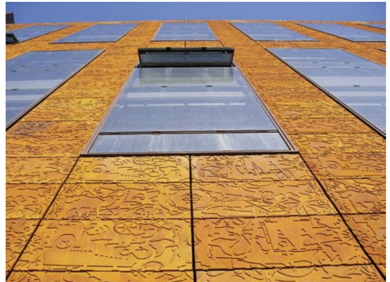
De oranje panelen zullen na ongeveer ene jaar donkerbruin verkleuren door de verandering van Fe_3O_2 in Fe_2O_3 .
