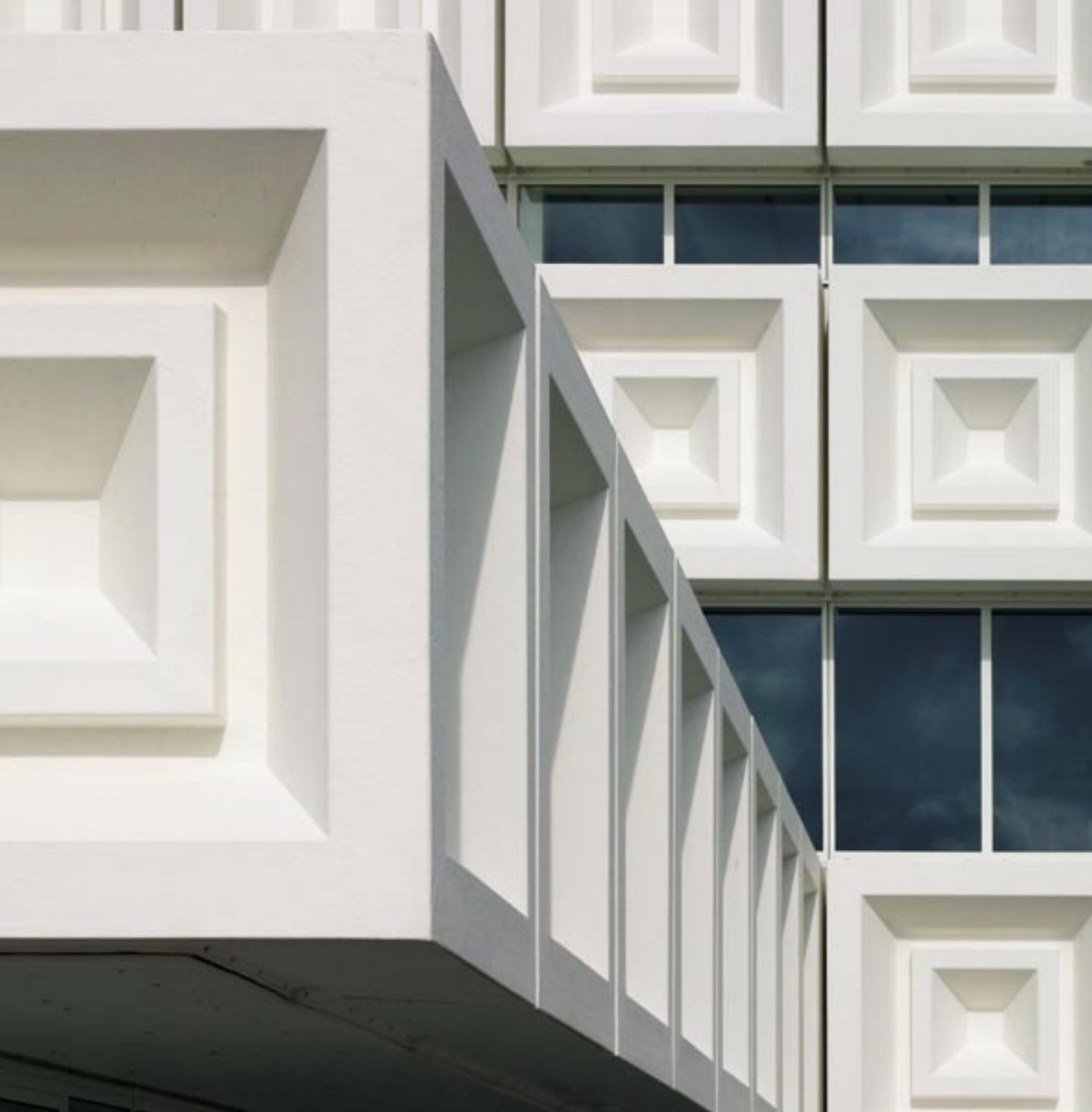
De polyester elementen verlenen de gevel van de school een grote mate van plasticiteit. Ze hebben een afmeting van twee bij twee meter wegen slechts 85 kg per stuk.
